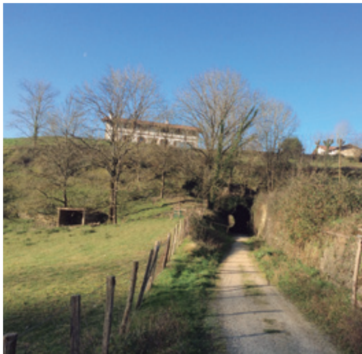
Konpondu eta argiztatu den trenbide zaharreko tuneletako bat. MAIDER ARREGI
