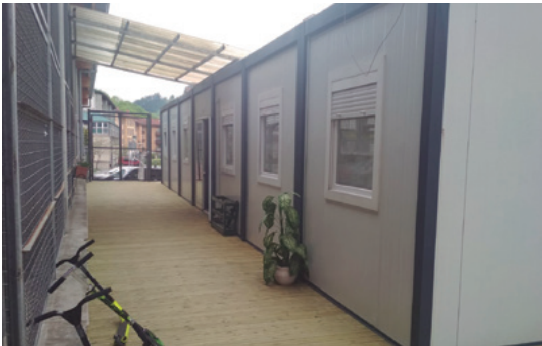
Gela aurrefabrikatuak eskolako patio ondoko aparkalekuan jarri dituzte. GOIENA
