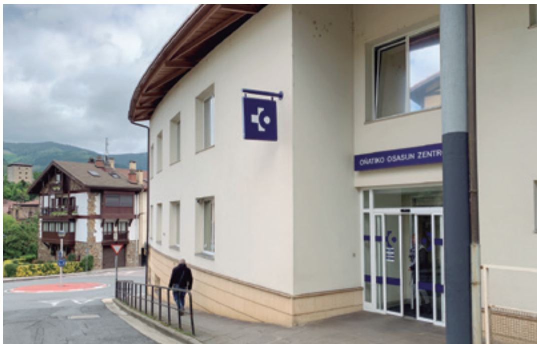
Herriko osasun zentroaren sarreretako bat. O.E.
