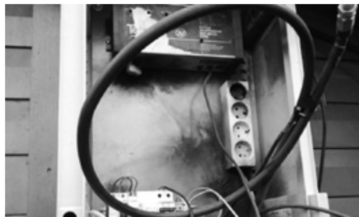
Kaxa elektrikoa erreta. JUANITO BENGOA
