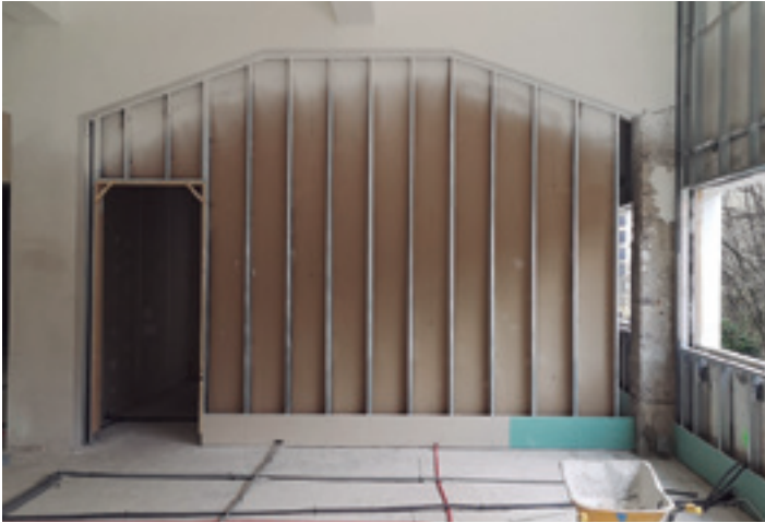
Eraikinaren estruktura eta barruko arkuak mantendu egingo dituzte. ENEKO AZURMENDI
