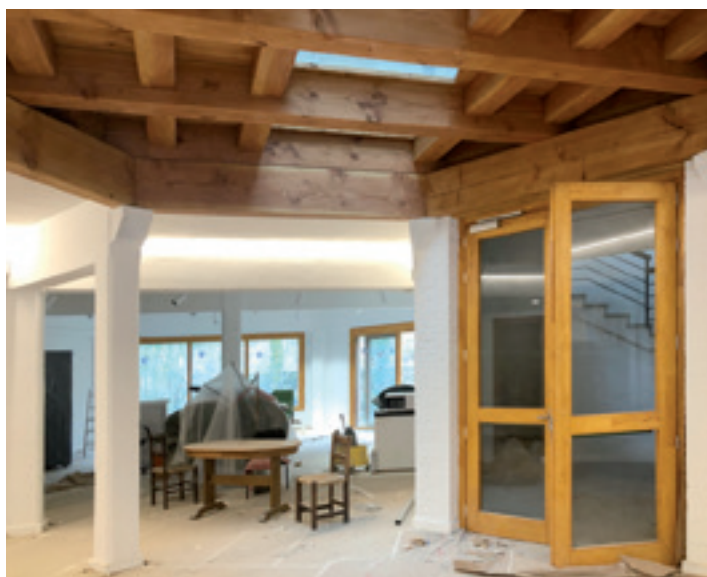
Lehengo zutabeak eta argia pasatzen uzten duen egurrezko sabai berria. O.E.
