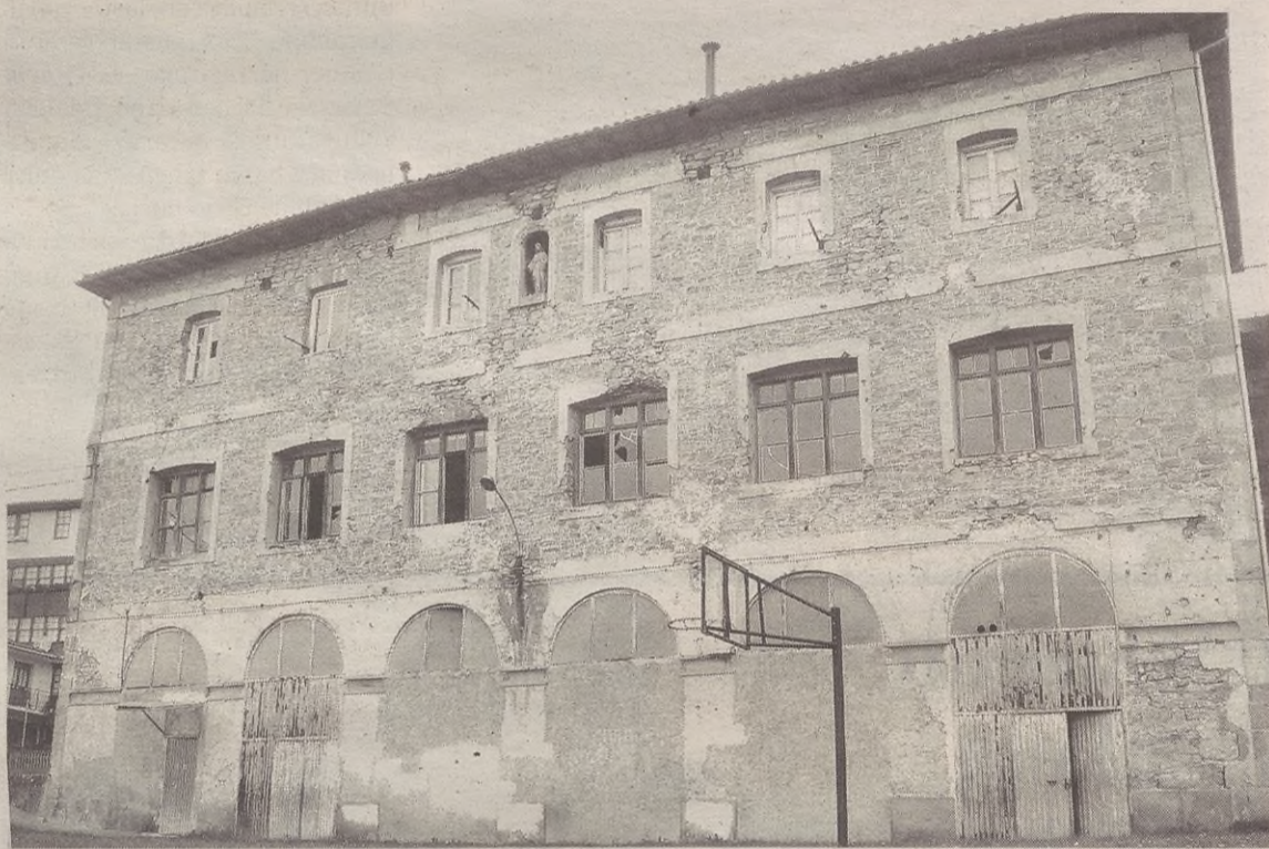
Domingo Iturbe eraikinak lau solairu ditu, eta, besteak beste, erakusketa gelak eta bulegoak ipini nahi dituzte bertan.
