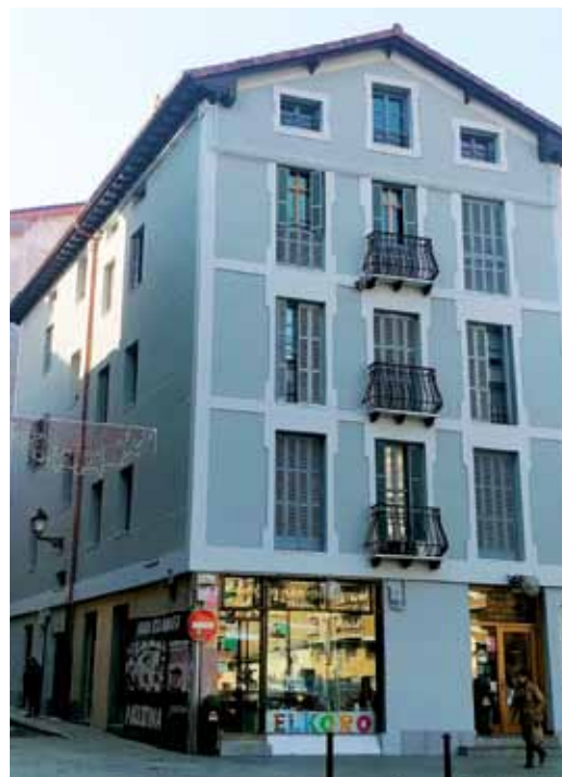
Fatxada, isolatu eta margotu ondoren. SURADESA
