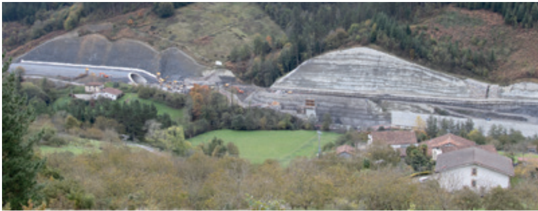
Ezkerretara, lurrazaleko tunela; aurrean, trenbidearen eremua, inguruan eustormak eraikitzen ari direla. ARGAZKIAK: IMANOL SORIANO
