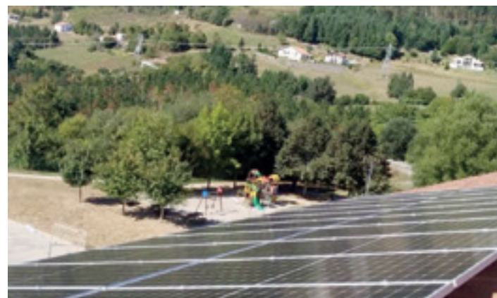
Plaka fotovoltaikoak frontoiko teilatuan. ELGETAKO UDALA
