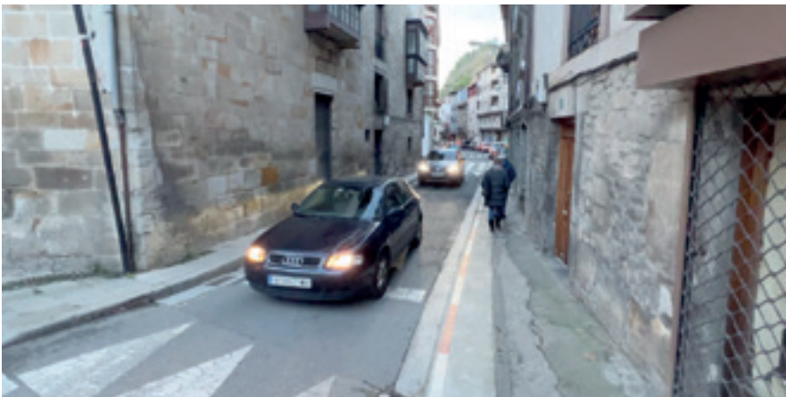
Masterrekako gune estuenean, espaloia zabaldua ere, trafikoa noranzko bakarrekoa izango da obra ostean.
