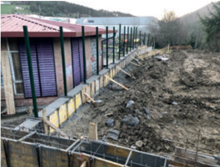
Pumptrack gunearendako hormigoizko horma egiteko lanak gaztetxe parean. L.Z.L.
