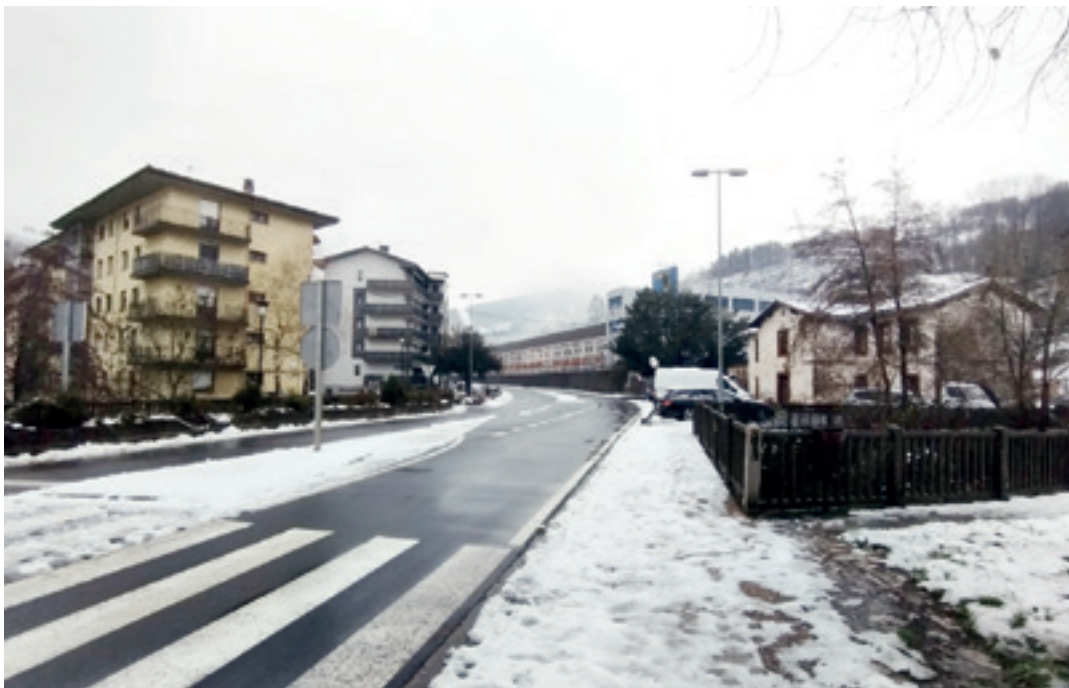
Eskuinean, Lazareto etxea, Errekalden; eraistean, aparkalekua eta parkea egingo dituzte, eta zirkulazioa egokitu. A.R.K.
