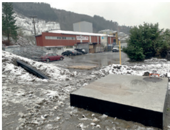
Hormigoizko blokea jarri dute, behin matxura konponduta. HASIER LARREA
