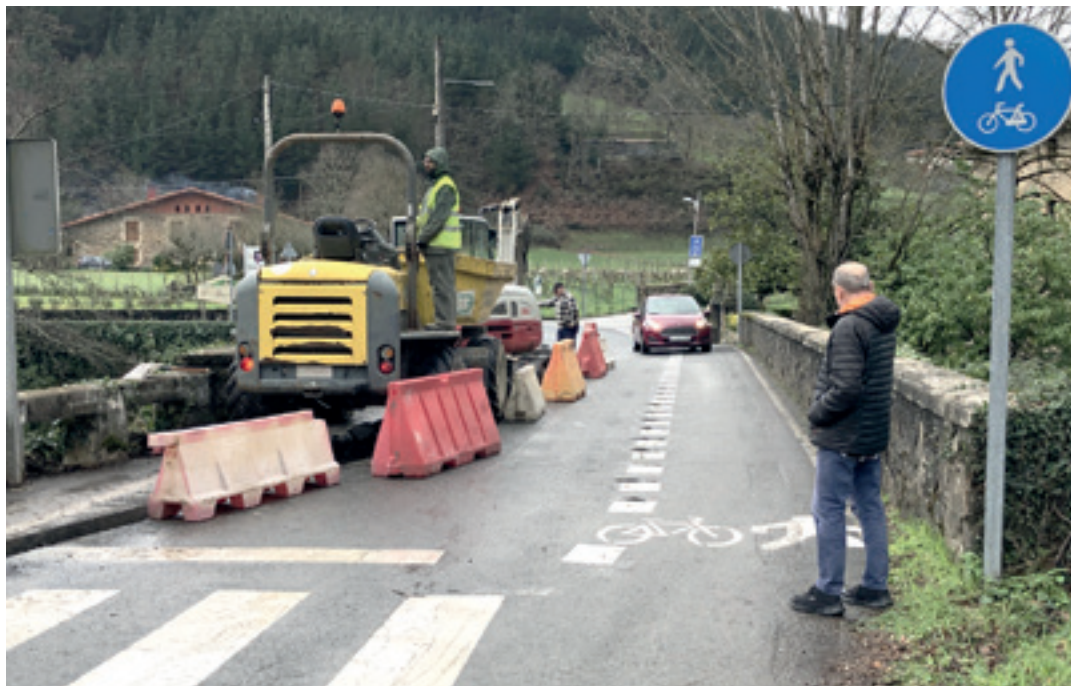
Torreauzoko zubiko lanetan langileak, martitzenean. IMANOL BELOKI
