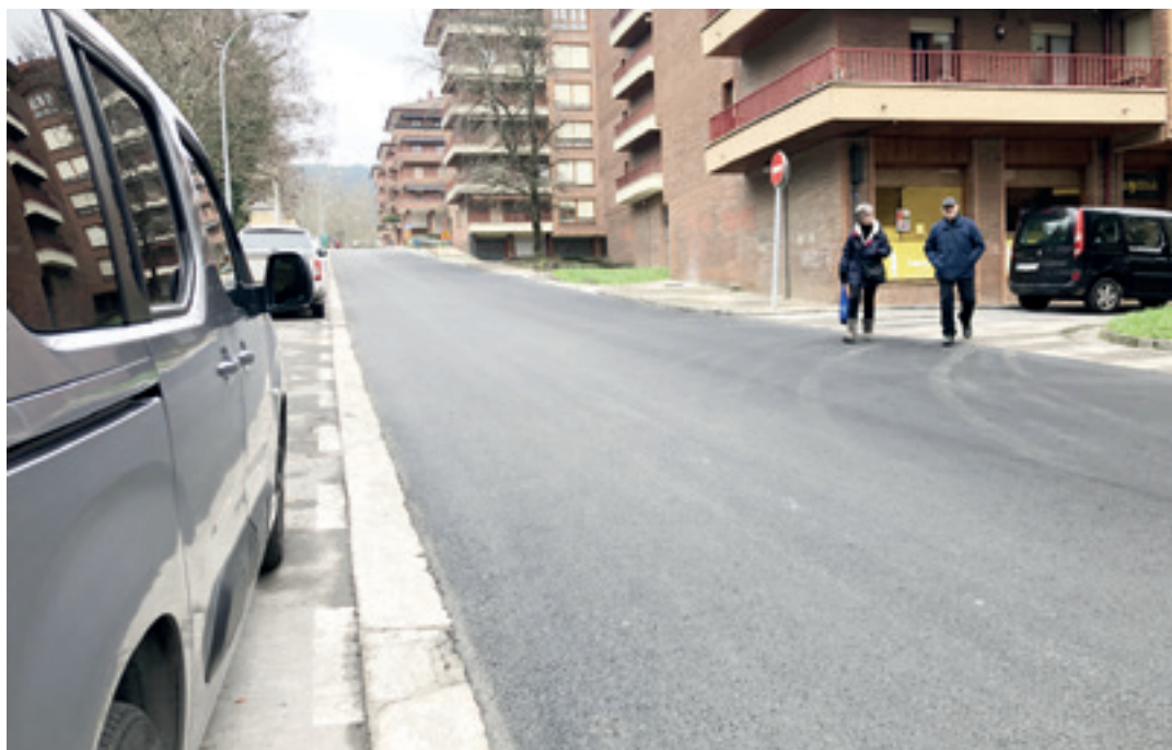
San Lorentzoko aldapetako bat, asfaltatze-lanak amaitu ondoren. O.E.
