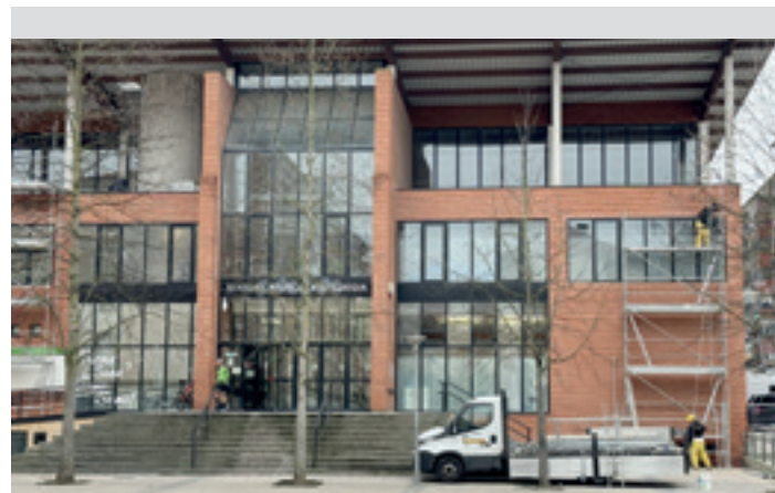
Martitzenean jarri zituzten aldamiok, obra egiteko materialak igotzeko. I.B
