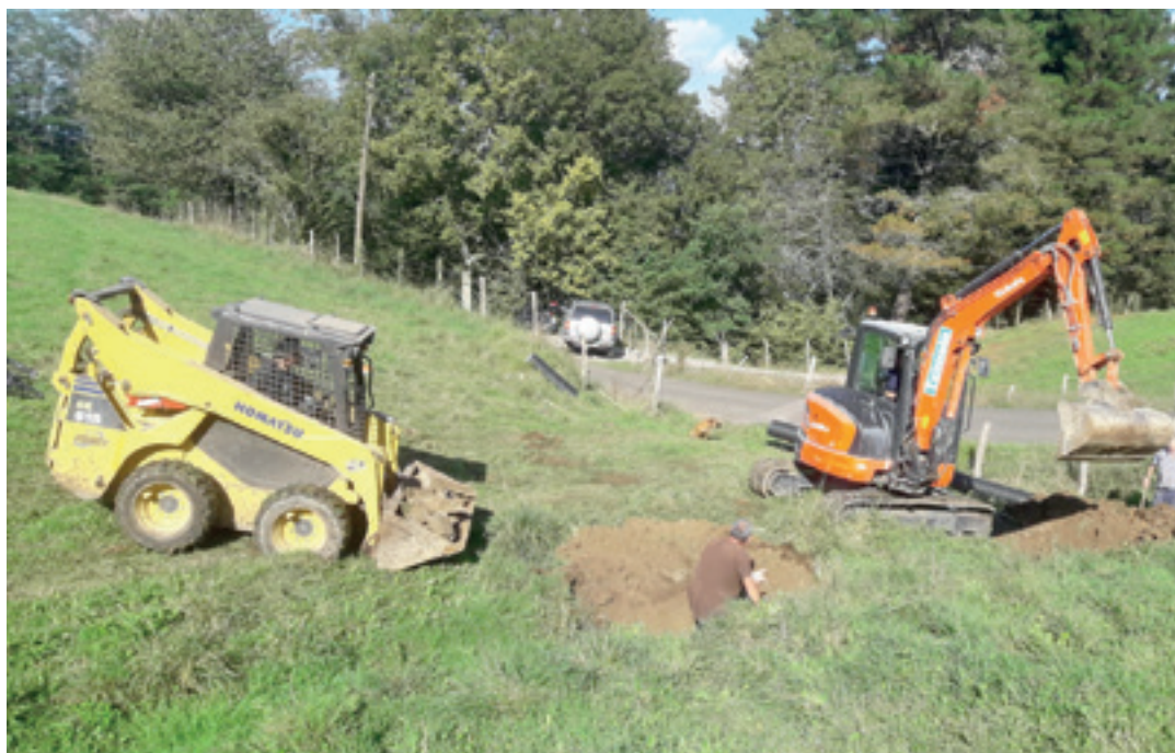
Makinak ur-hoditeria sartzeko hondeaketa lanak egiten, Galartzan. IOSU ITURRIZA
