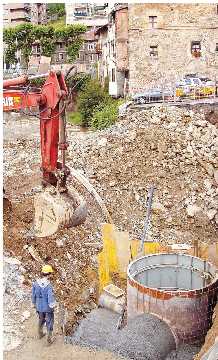
Errekan eta hainbat kaletan dabilta lanean, Bergaran, kolektorea dela-eta. ENEKO AZKARATE
