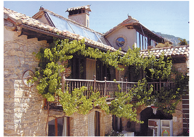
ENERGIA Bioarkitekturak energia aurreztearen defentsa du. AGIRIANO
