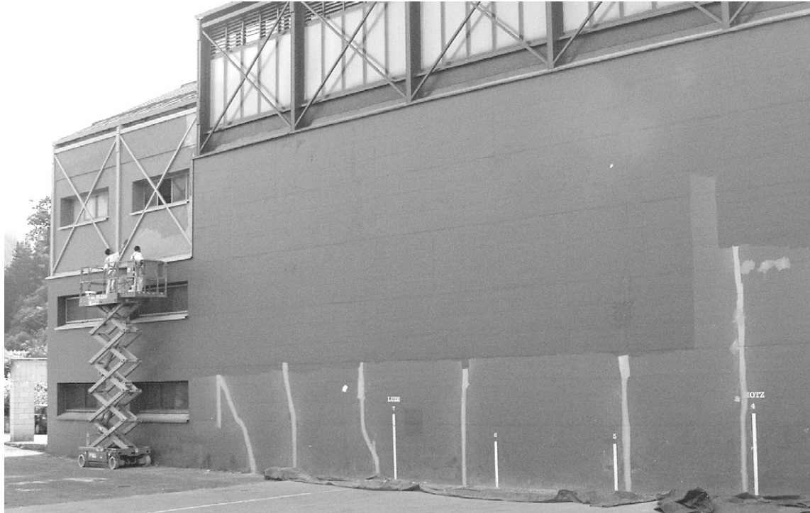
MARGOTZEN Egunotan, kanpoko pilotalekua margotzen dabilta, baina paretetako arrakalak kentzeko lanak ere egin dituzte. U.M.
