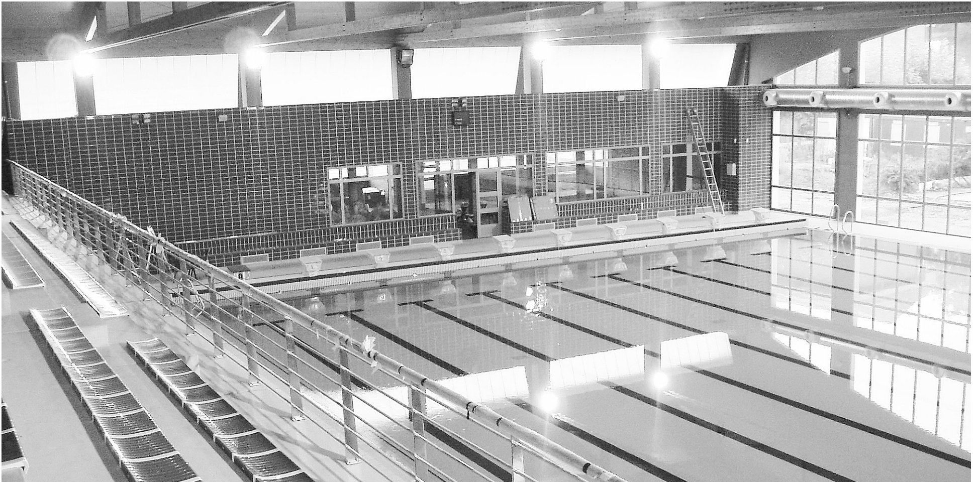
BERRIA Duela lau urte itxi zituzten lehengo igerilekuak eta orain arteko putzua zapatuan itxiko dute, instalazio berriak erabiltzeko gertu daude dagoeneko eta.
