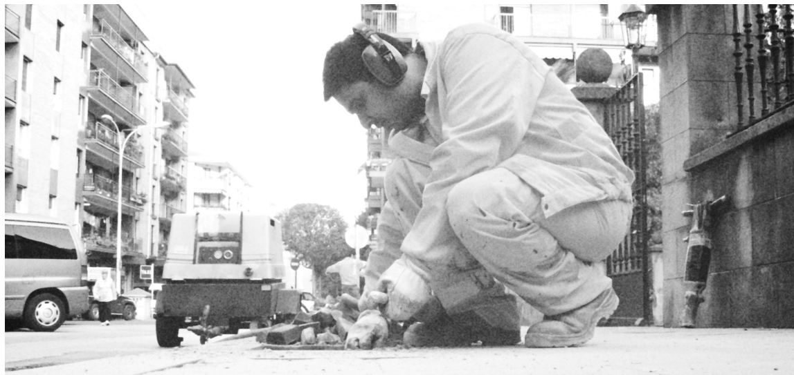
IRIZAR KALEA Egun hauetan Irizar kaleko espaloiko lur-lauza solteak kendu eta berriak jartzen ibili dira langileak. XABIER URTZELAI
