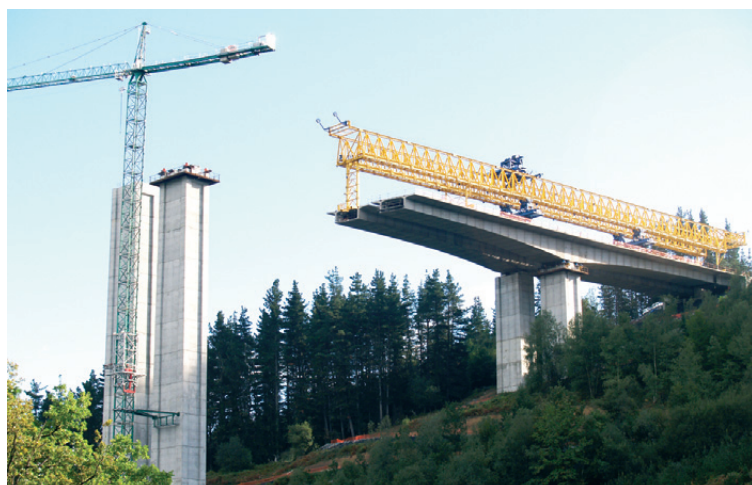
Maringo zubia eusten duten pilareek 100 metro luze dituzte. x.u.
