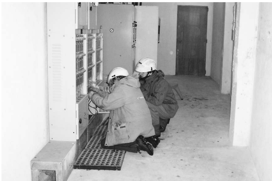
OINAZTUAK Iberdrolako langileek behin eta berriz etorri behar izaten dute erretako fusibleak aldatzera.
