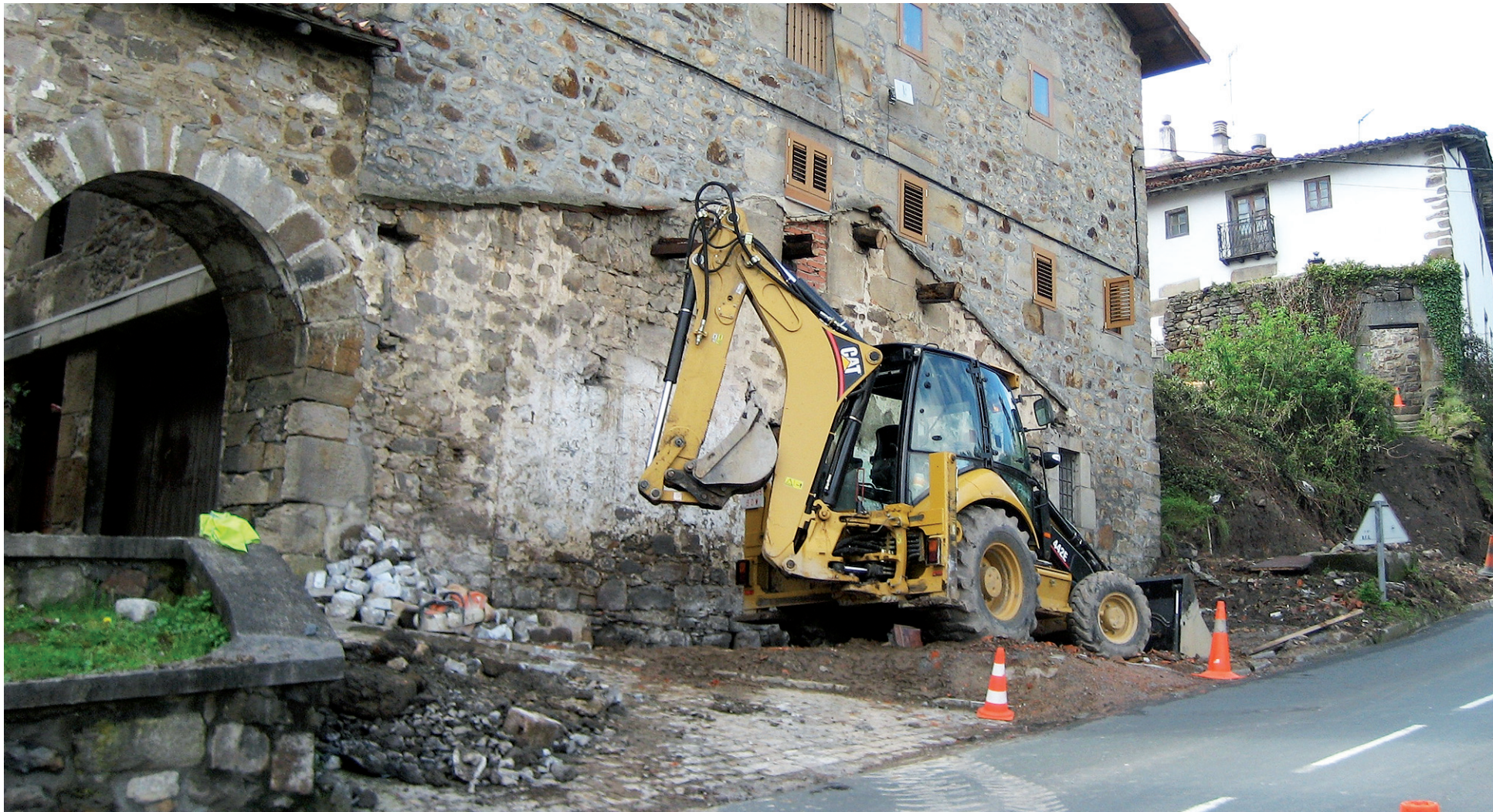
LANAK Bigarren faseko azpiegitura lanak egiten Gatzagako kaleetan, saneamendu hodiak aldatu eta gasarenak sartzen. MIRARI ALTUBE
