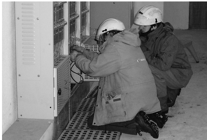
Iberdrolako langileak, kaltetutako transformadore bat konpontzen.
