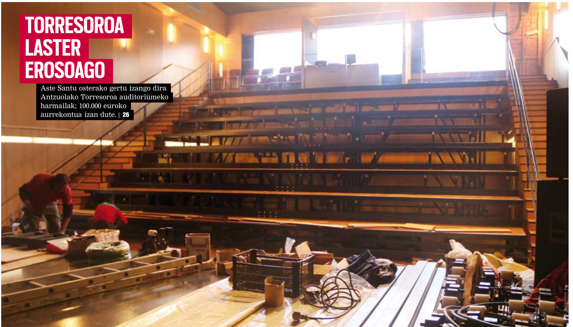
Langileak harmaila berriak jartzeko lanak egiten; harmaila teleskopikoa dihardute eraikitzen, 167 aulki izango dituena. | JAGOBA DOMINGO
