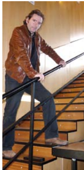
Valen Moñux, barandak instalatzen. | M.A.
