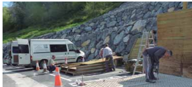
Aparkaleku berria bukatuta, eta auzo-konpost guneako obrak. | UBANE MADERA
