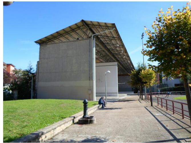
2 frontoien sabaia berritzea eta alboko aldea estaltzea
