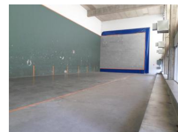
Frontoi txikia Paretak iragazgaiztu beharra. Gortinen sistema jartzen da espazioa erdibitu ahal izateko.
